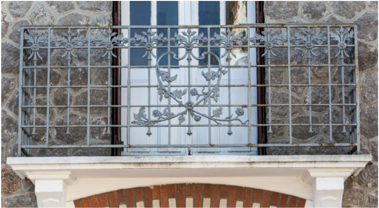
Maison, 83 rue Joseph-Tahet. Détail du cadre-corps en ferronnerie.
