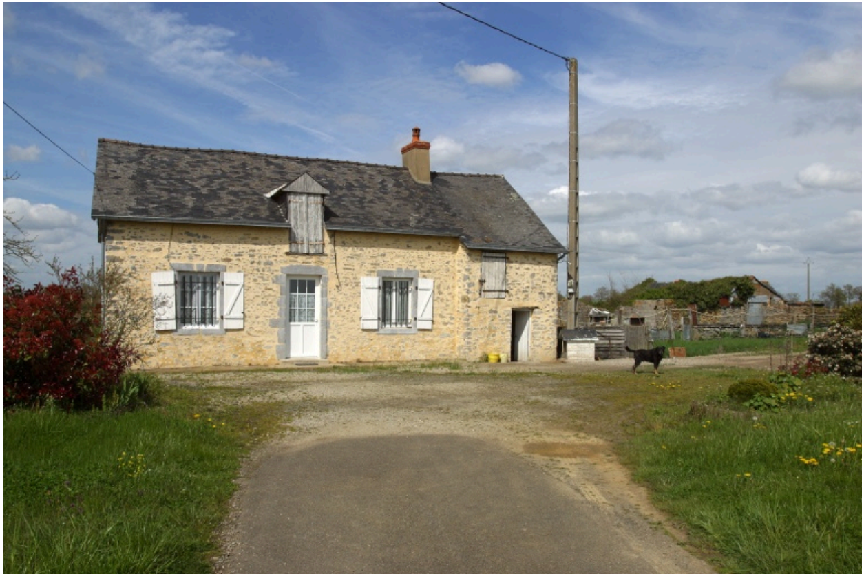
Le logis et l'étable ruinée vus depuis le chemin d'accès au sud.
