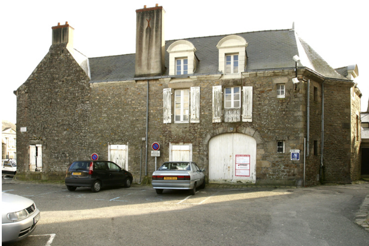
Elévation sur rue de l'aile est.
