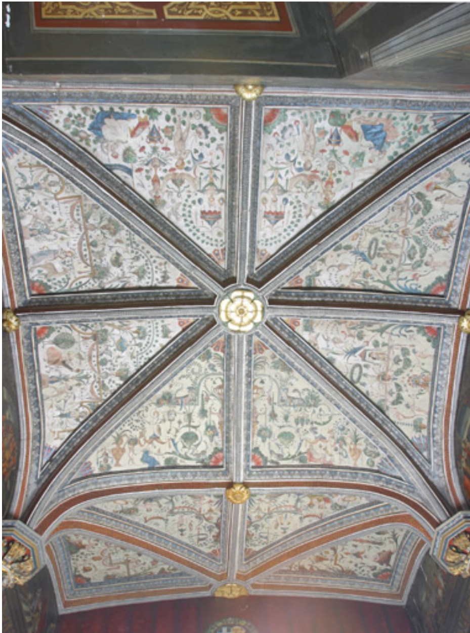
Voûte d'ogives déprimée : vue d'ensemble d'une croisée et demie.
