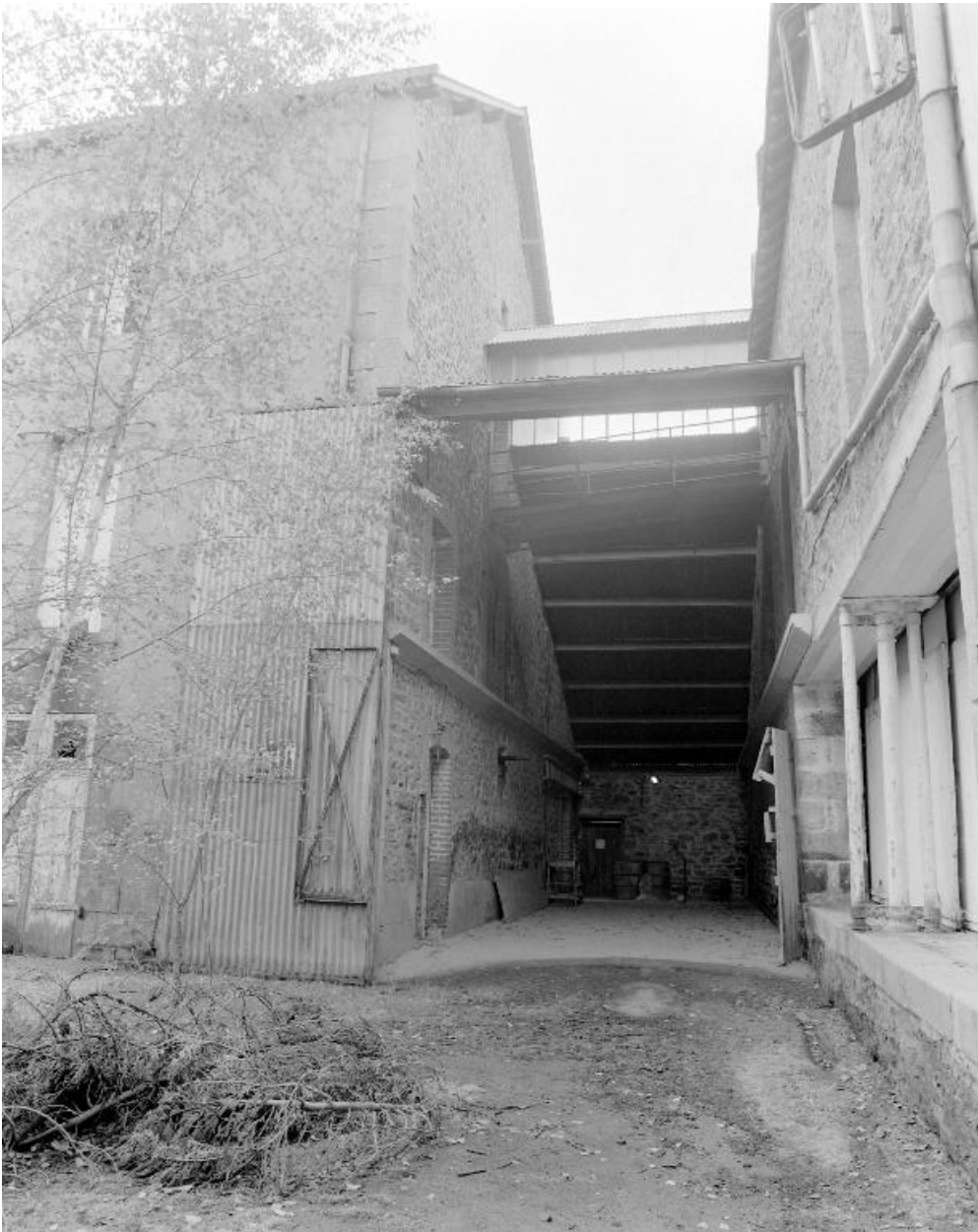
Le passage couvert et la passerelle reliant le moulin (à gauche) au bâtiment servant au stockage des céréales et de la farine (à droite).
