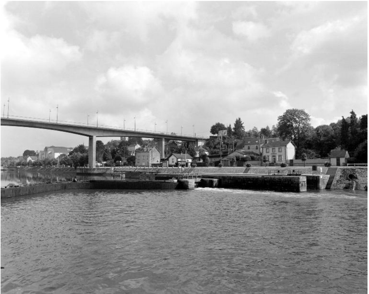
Le barrage, le pertuis, l'écluse et la maison éclusière vus depuis la rive droite.
