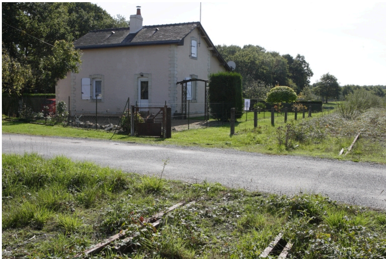
Arrêt La Cantraie.
