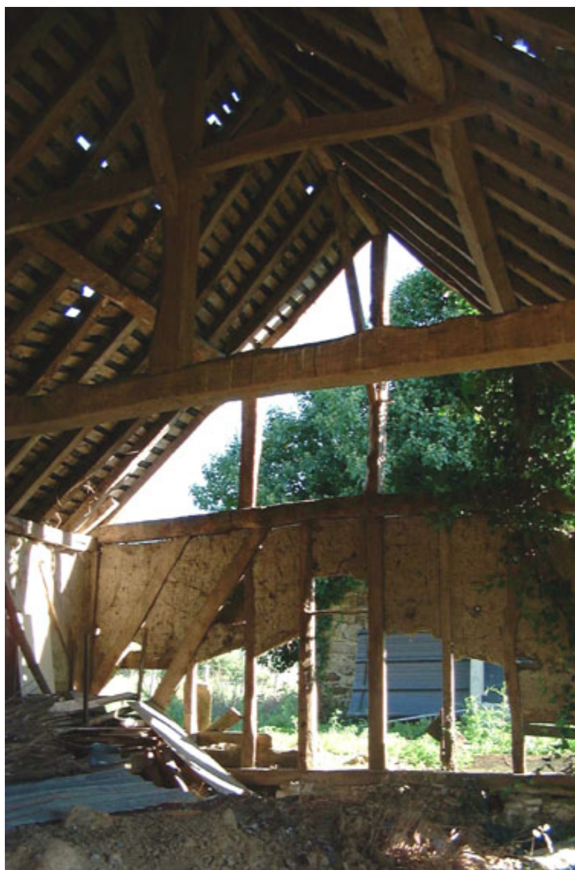
Pan de bois et charpente à pannes.
