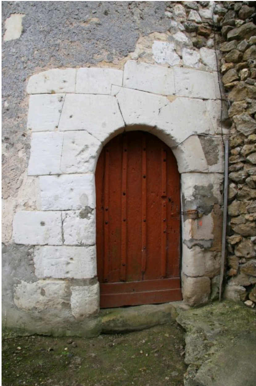
Tourelle : porte d'entrée.
