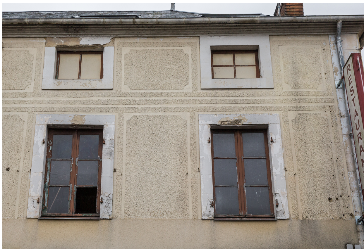
Un détail de la façade principale.
