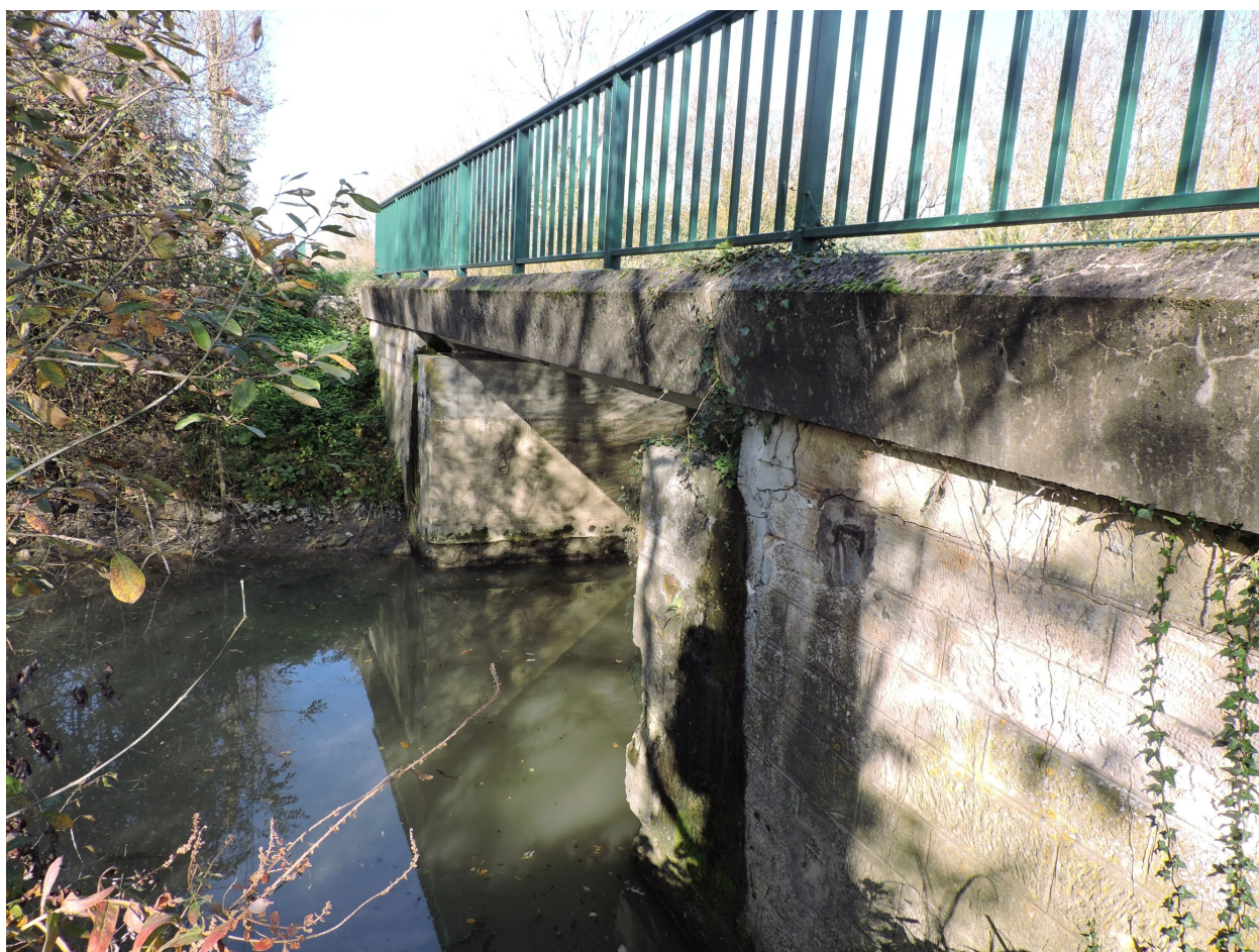
Le pont sur le Contrebot de Vix vu depuis le sud-ouest, côté aval.
