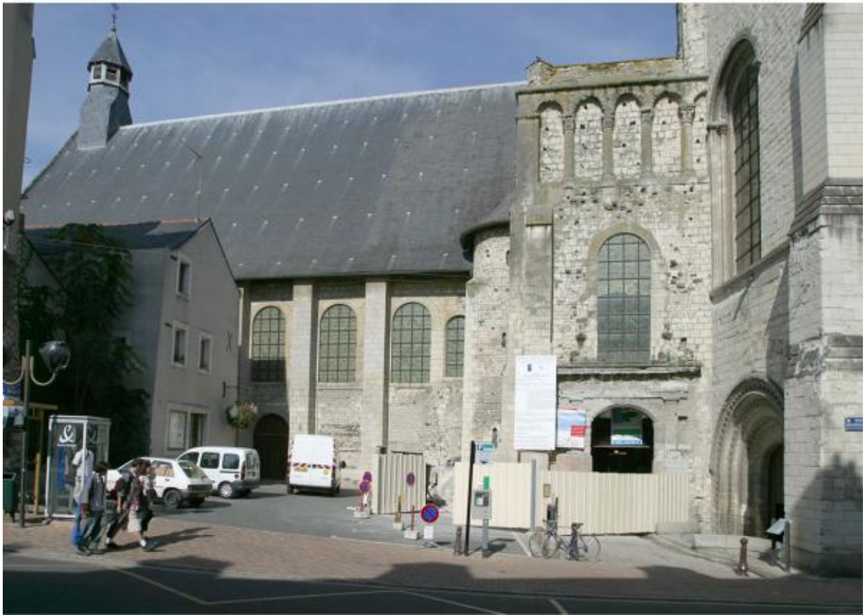
Vue de situation à l'ouest, sur la place.
