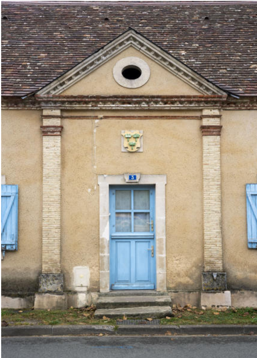
Travée centrale de la façade principale des anciennes écuries, aujourd'hui maison.
