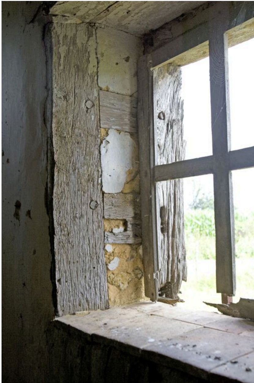
Détail de la baie de la chambre froide.
