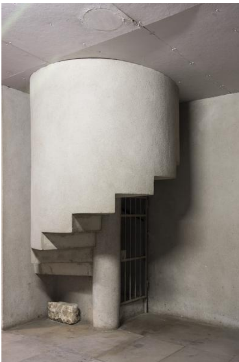
Vue de l'escalier gauche montant à la tribune.
