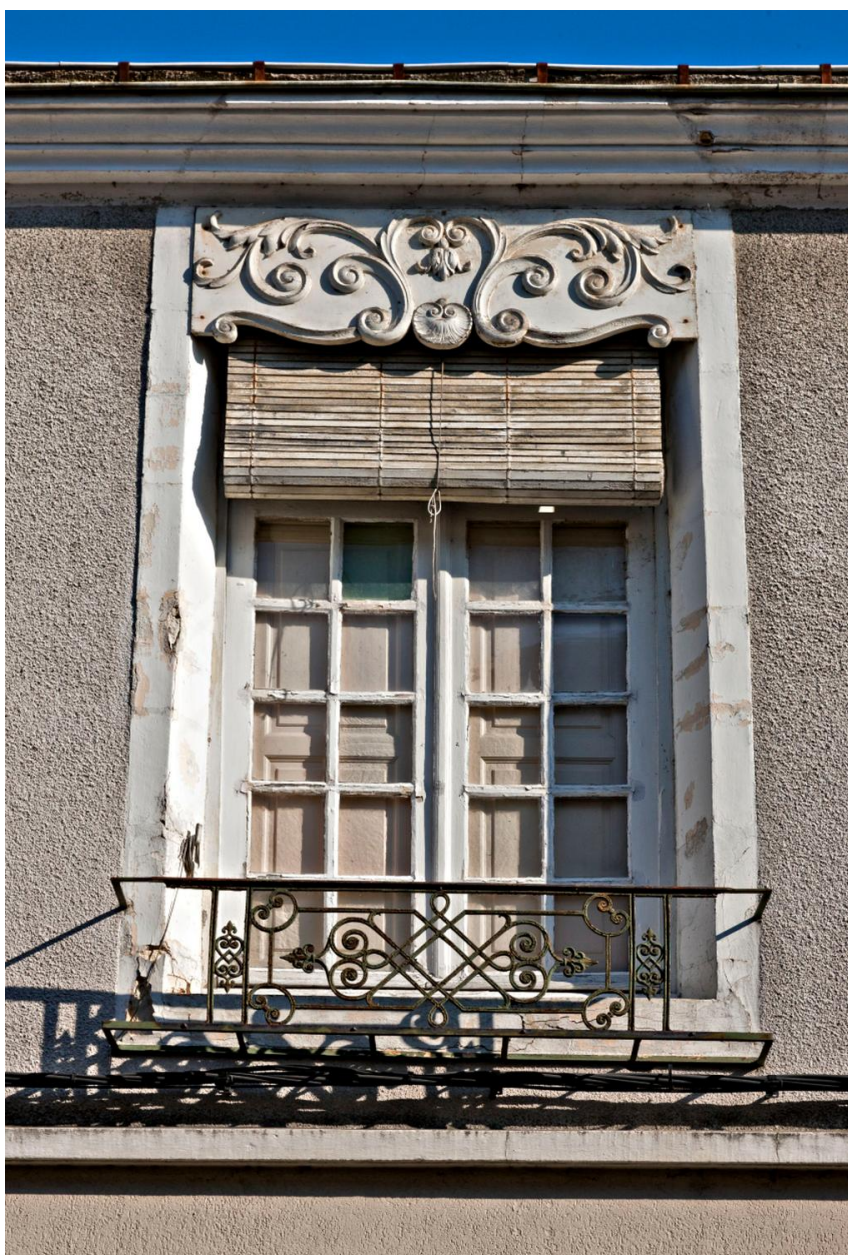
Baie du premier étage : menuiseries anciennes.
