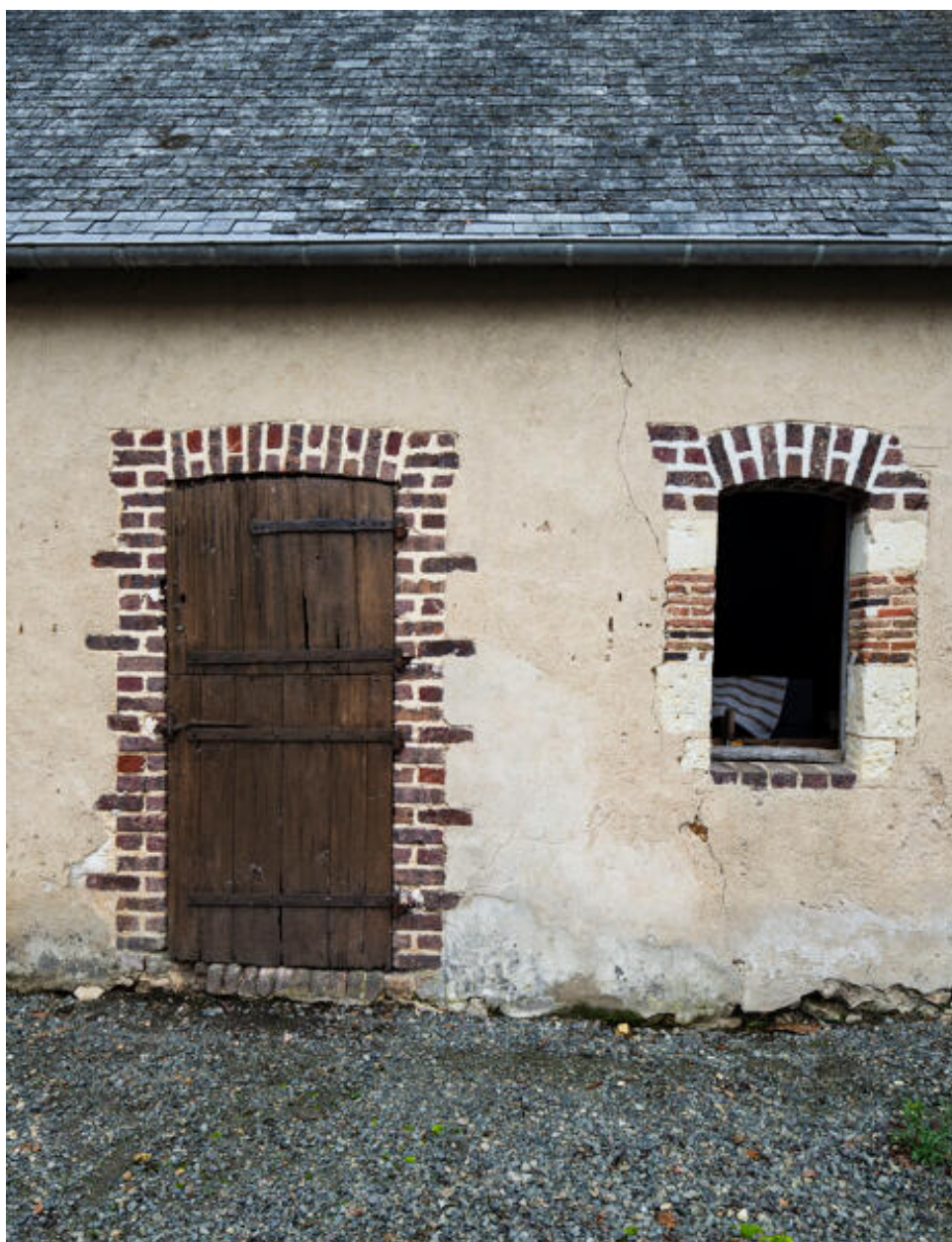
Logement : porte et fenêtre.
