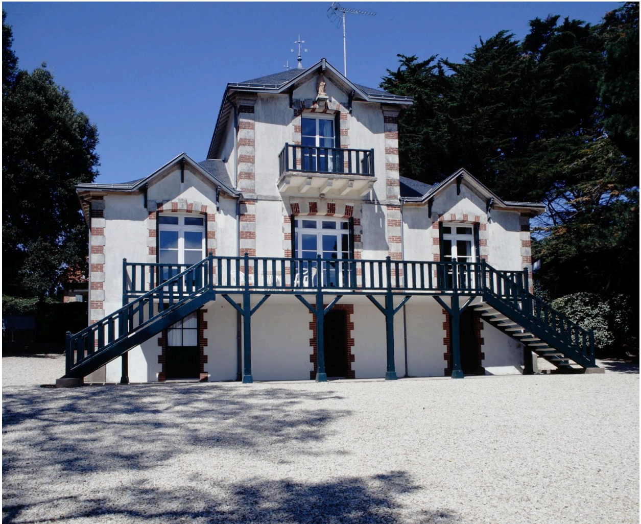
Elévation sud de la villa.
