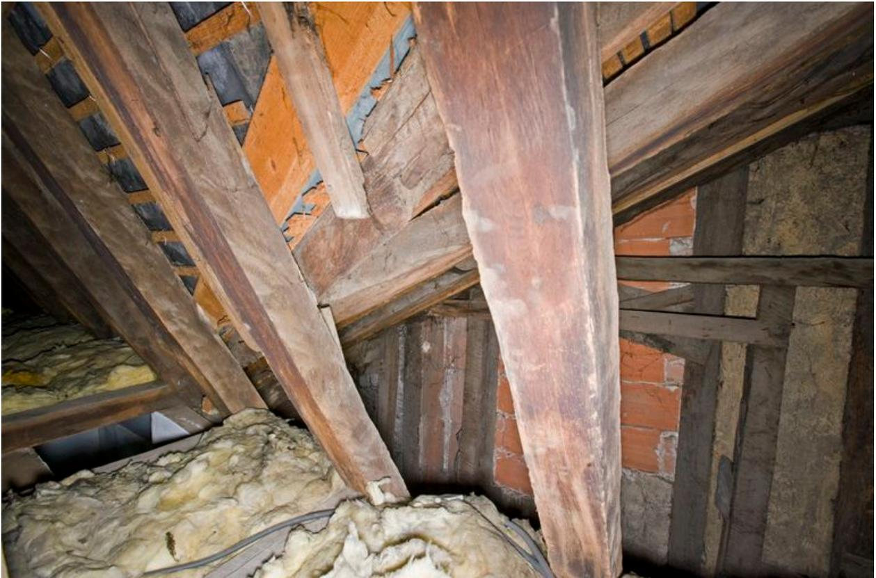
Charpente : chevrons-arbalétriers du long pan gauche, chevron de noue et chevrons de l'appentis latéral d'écoulement des eaux. En fond, les élévations latérales parallèles en pan de bois de la maison et de la voisine au n° 57.
