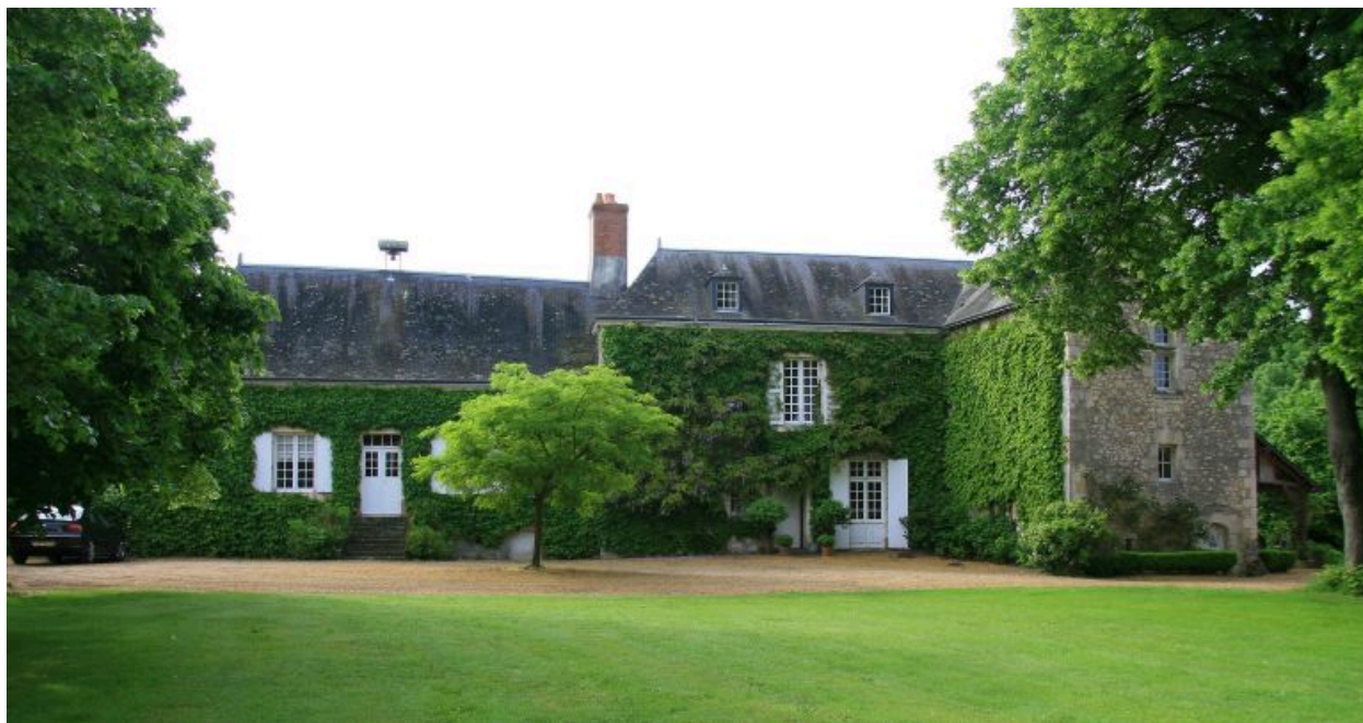
Façade antérieure sur cour.
