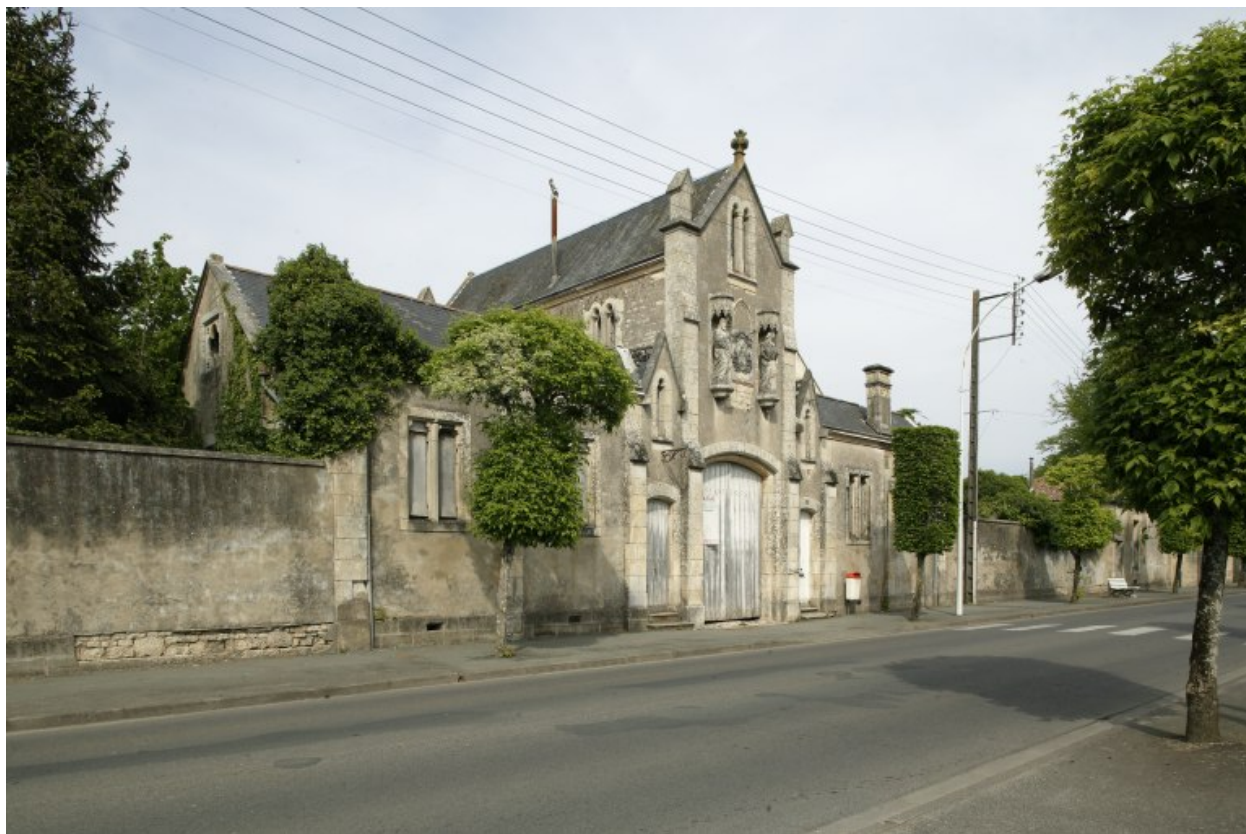
Pavillon d'entrée (vue prise de la rue du Président-de-Gaulle).
