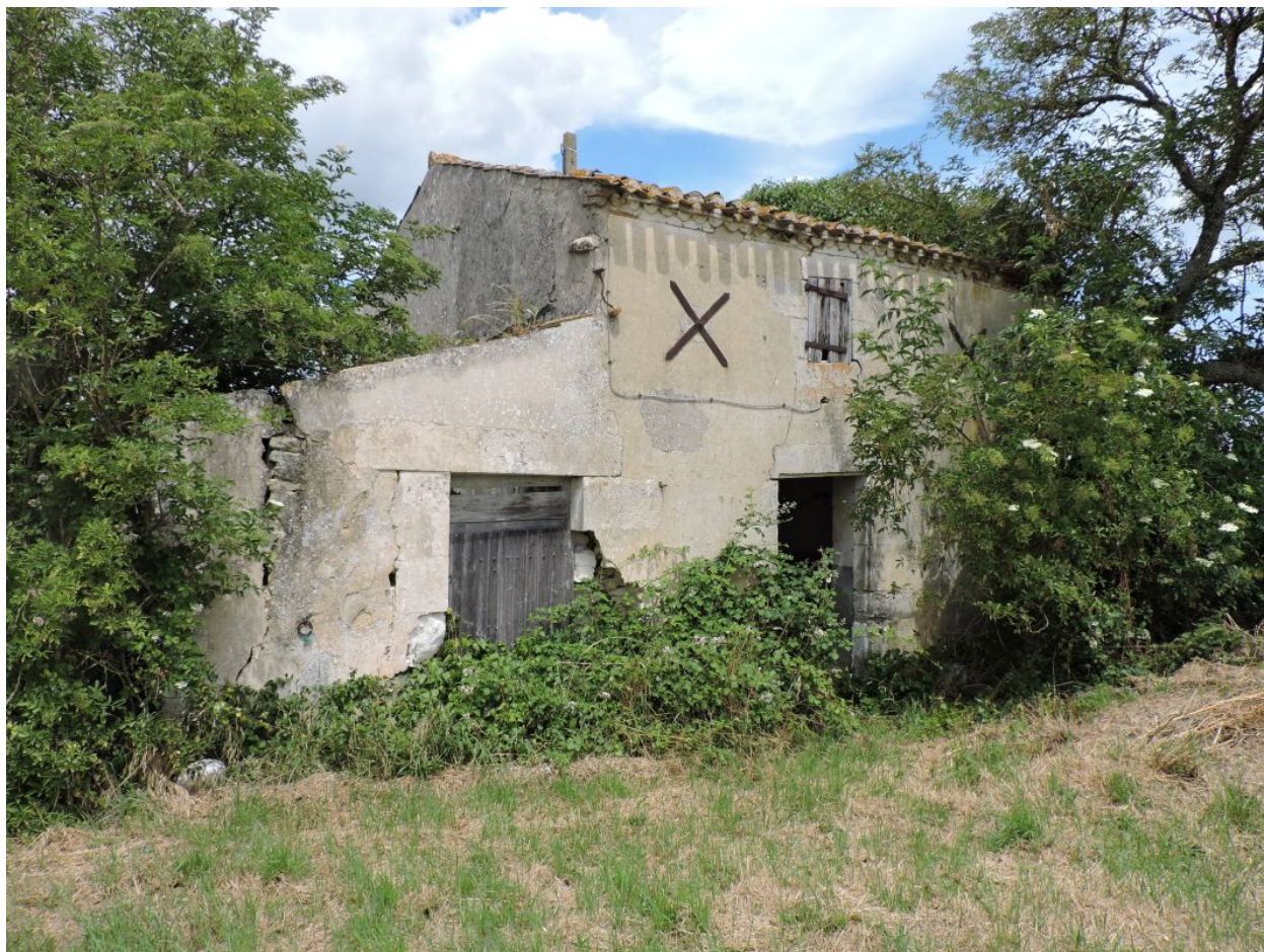
La maison vue depuis le sud-est.
