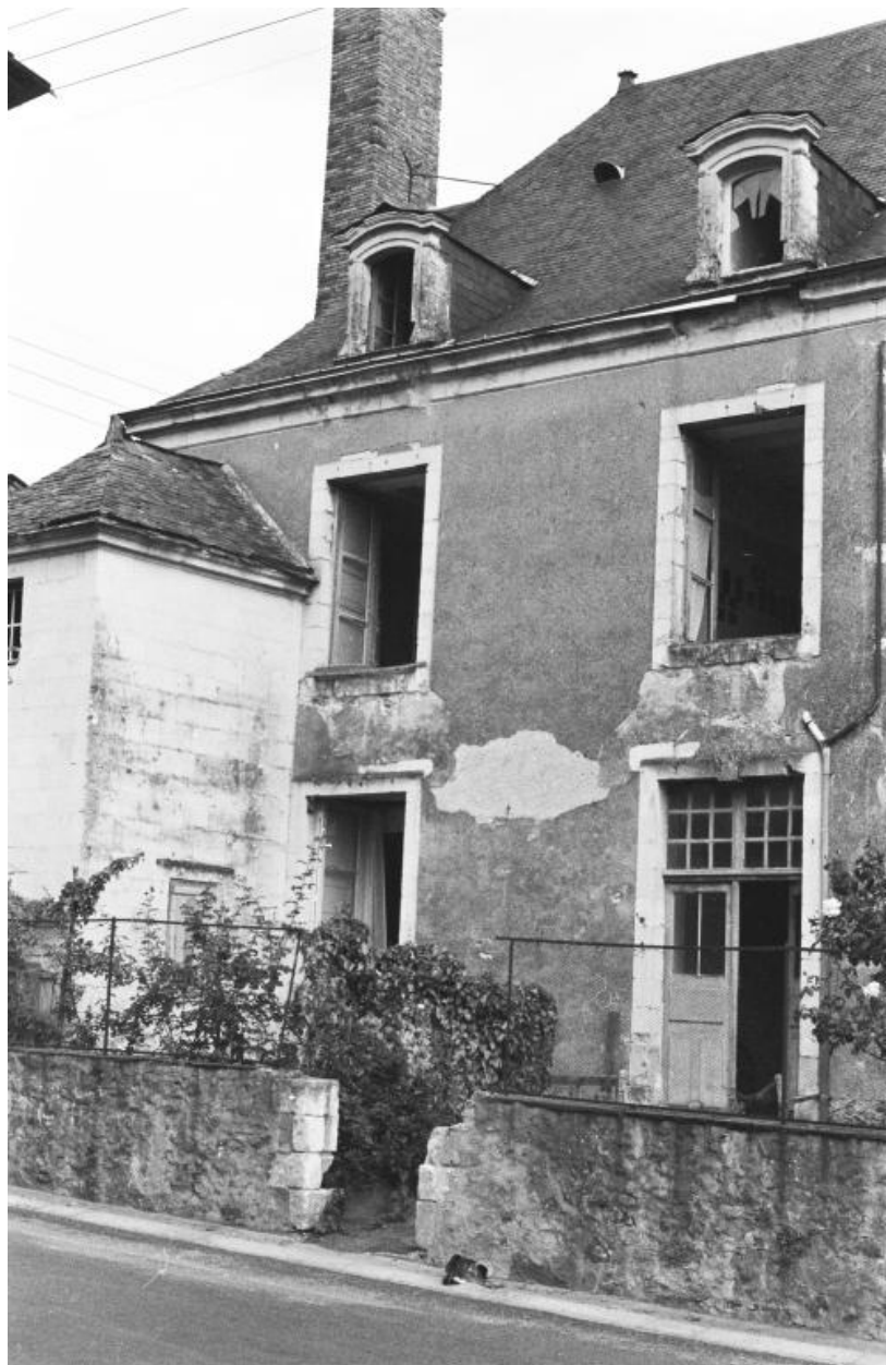
Façade postérieure, côté gauche.
