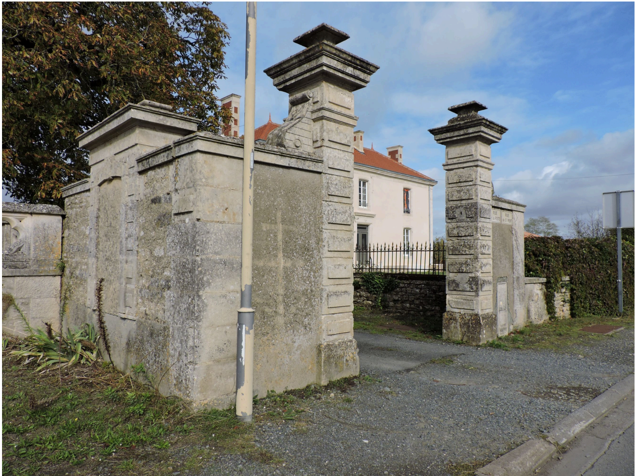
Le portail au sud-est de la propriété, près du calvaire, vu depuis le sud-ouest.
