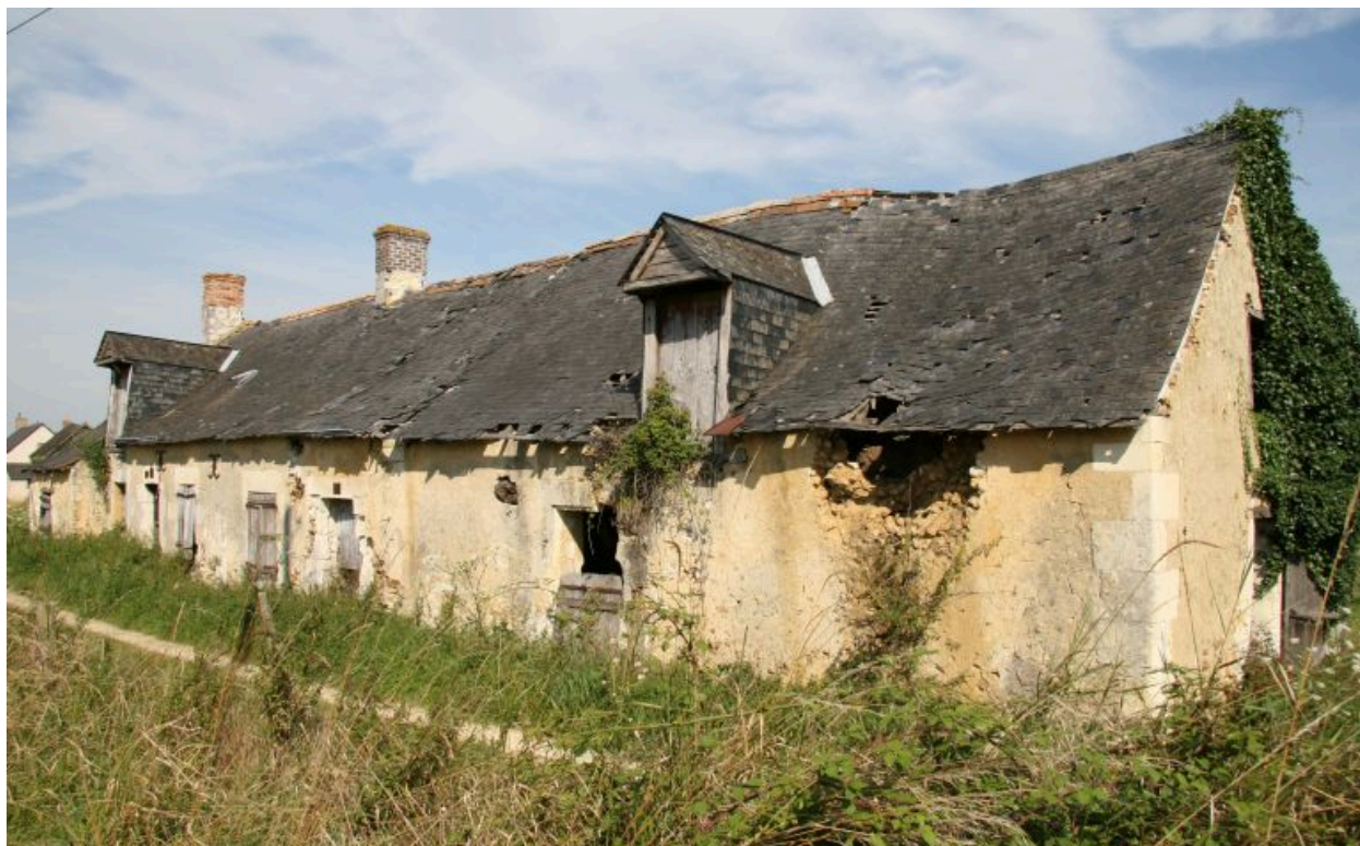
Vue d'ensemble de la façade sur le chemin.
