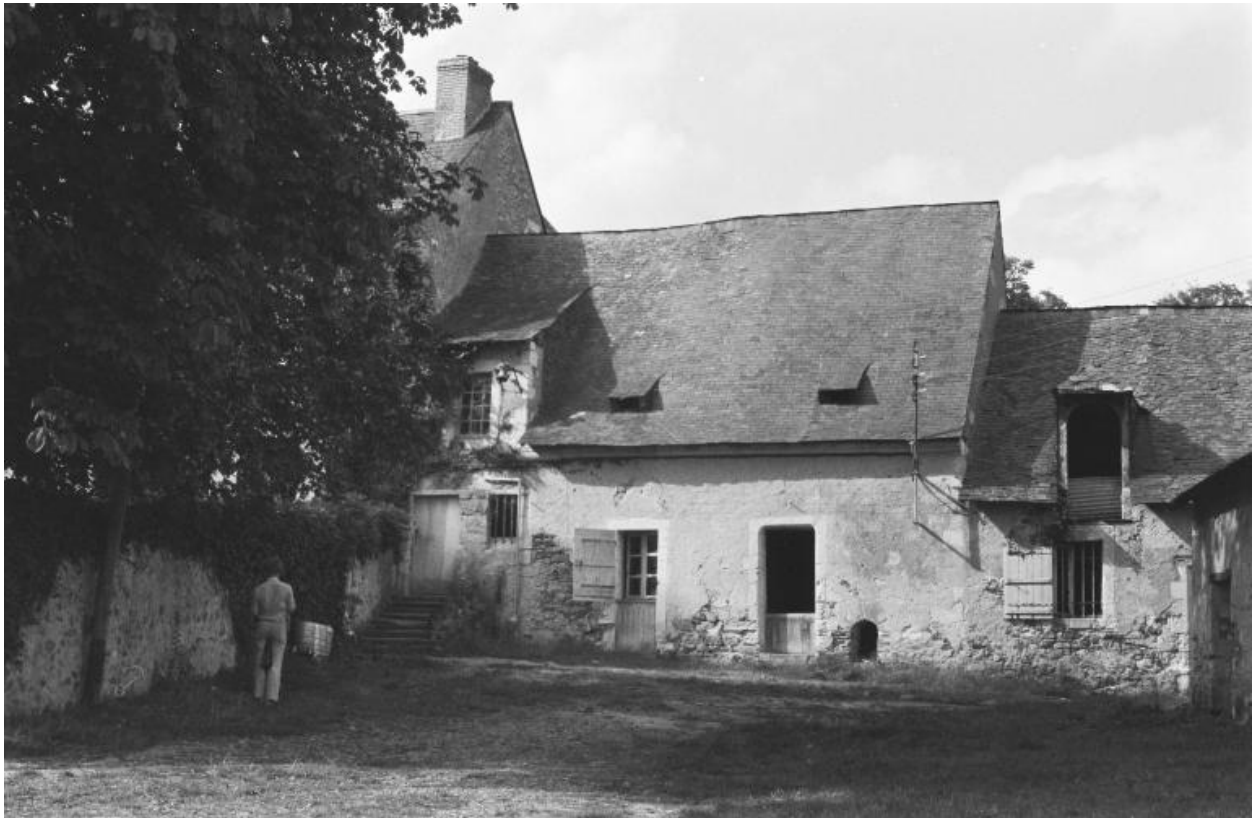
Façade sur cour des dépendances situées dans le prolongement du logis.
