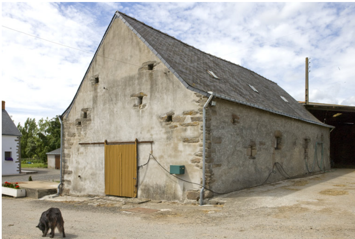
Logis. Vue depuis le sud.
