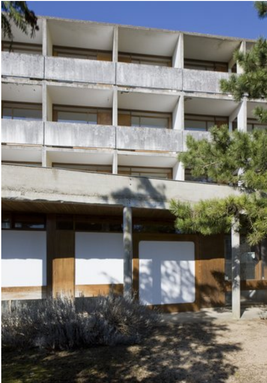
Détail de la partie est de la façade sur jardin.
