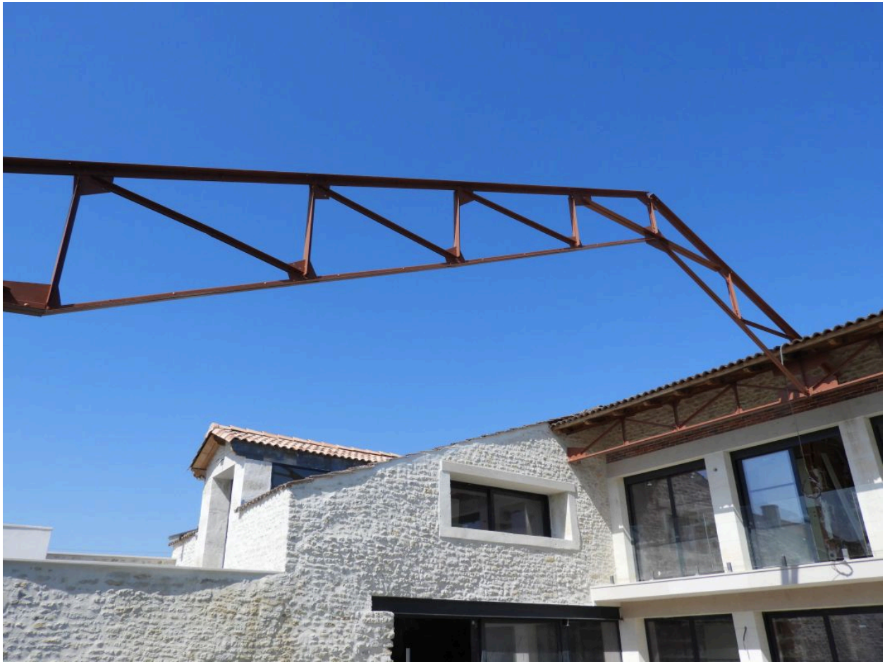
Vestige de la charpente métallique de l'ancienne salle de bal.
