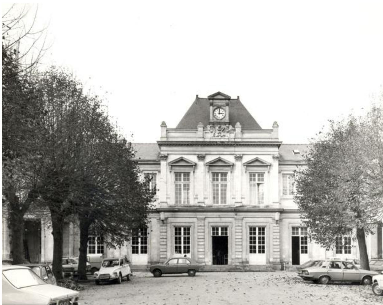
Cour des "Arts-et-Métiers". Pavillon central en fond de cour.
