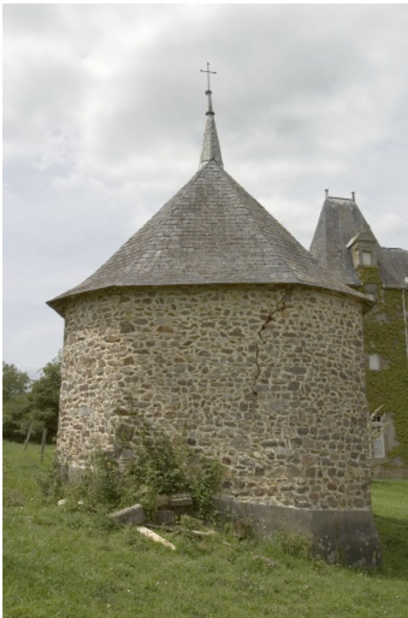
La chapelle vue depuis l'est.
