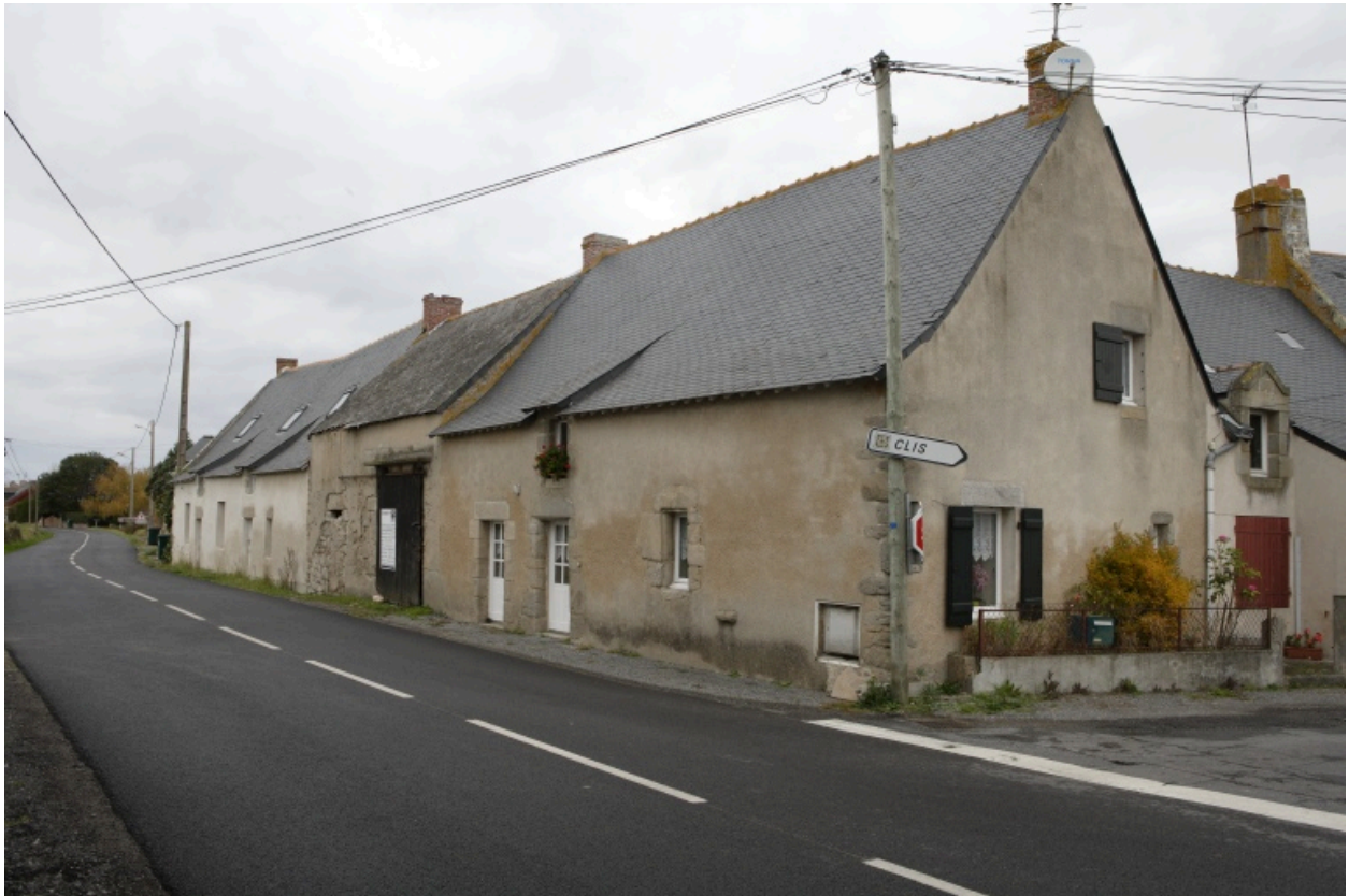
Vue d'ensemble des 3e, 4e et 5e logis depuis le sud-est.
