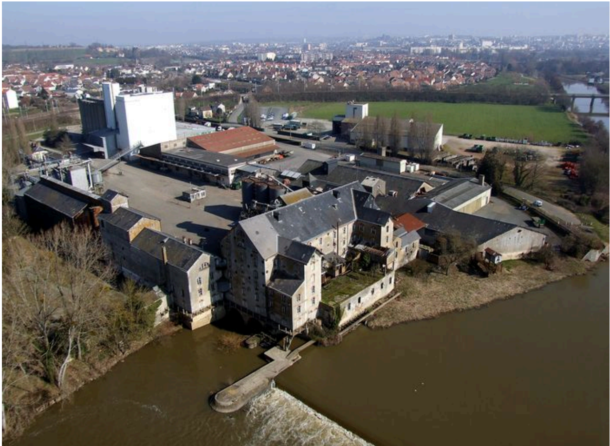
Vue d'ensemble de la minoterie avant sa destruction.
