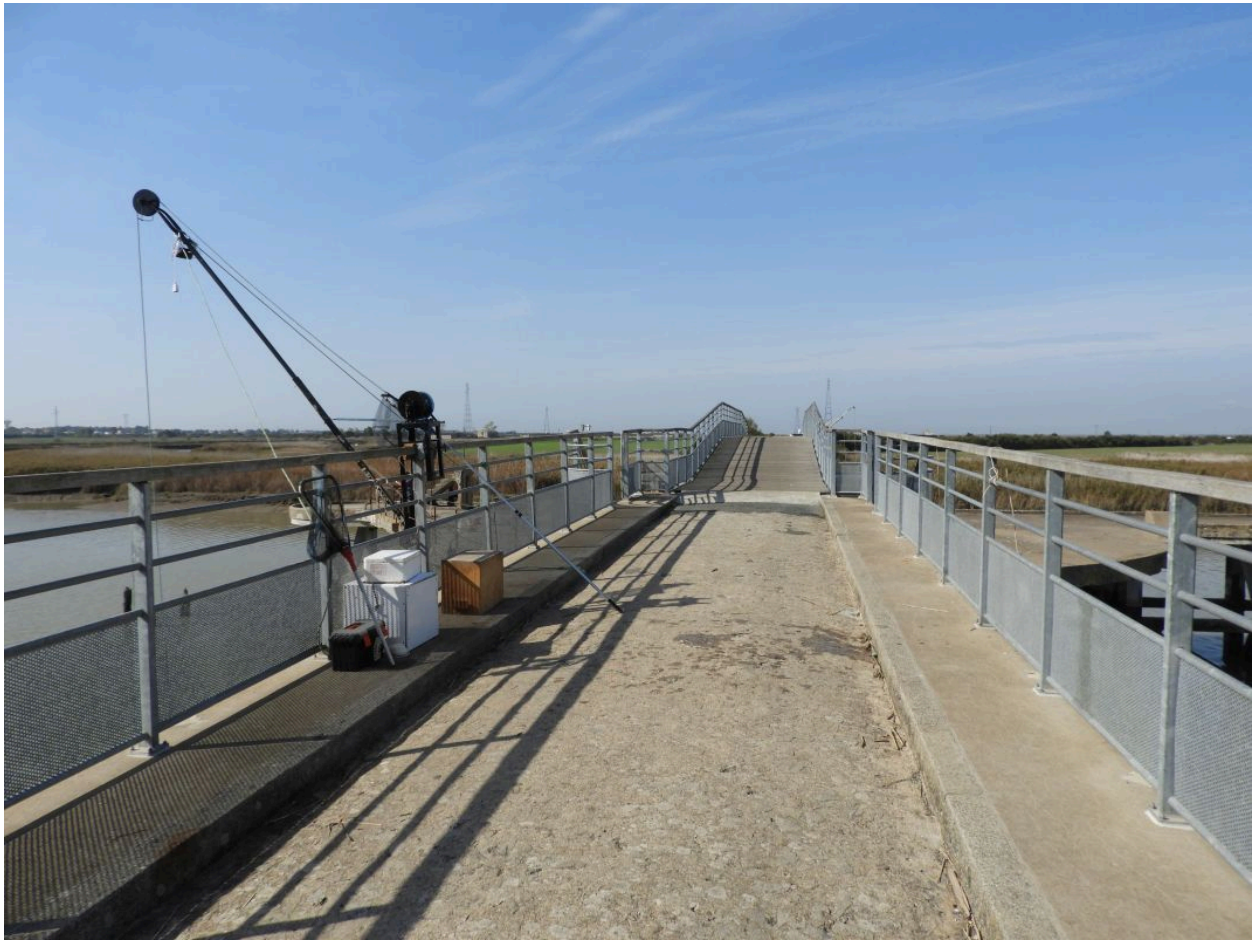
Le pont et la passerelle construite par-dessus en 2012, vus depuis la rive gauche, à l'est.
