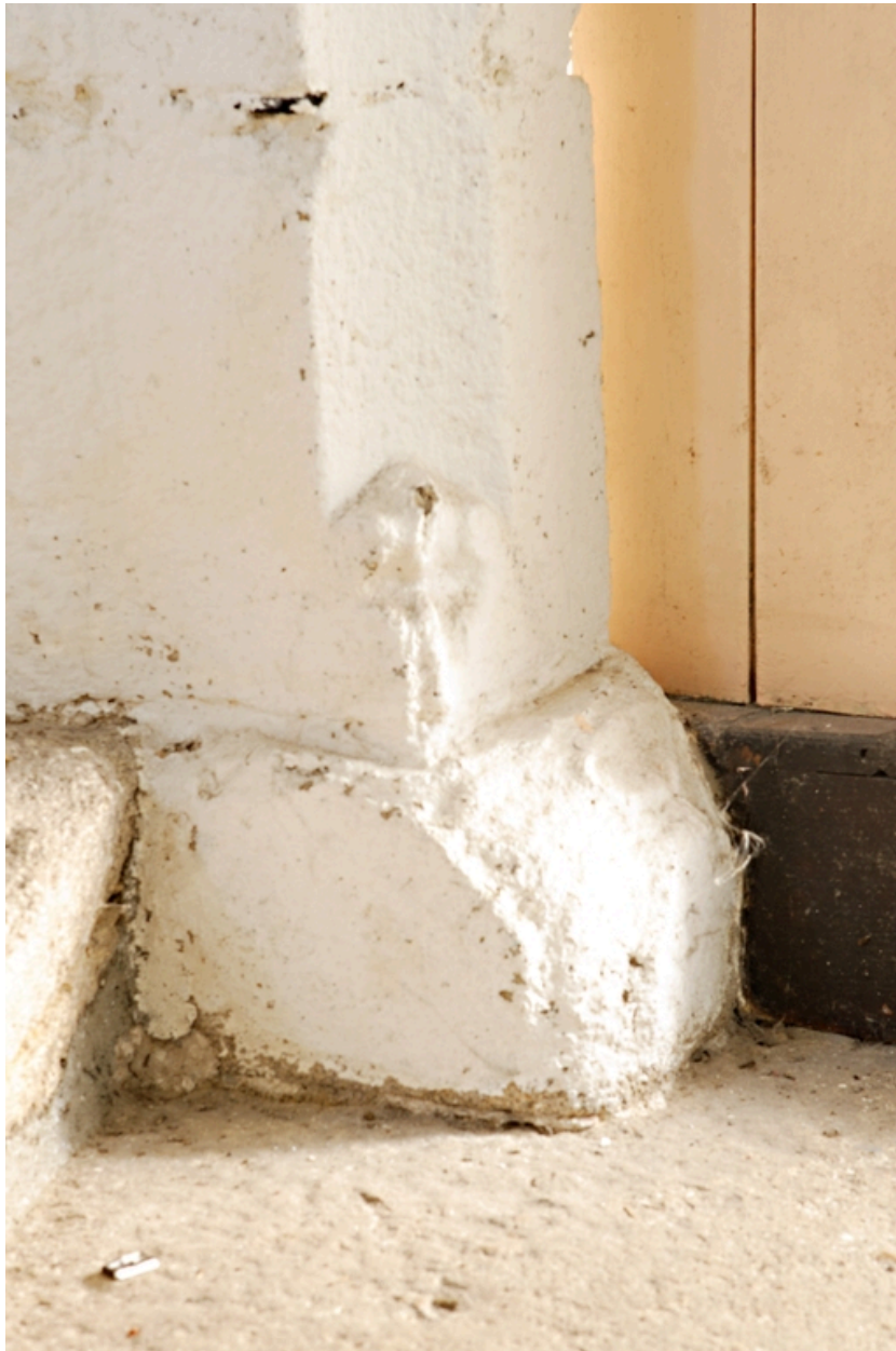
Aile ouest. Étage de comble. Détail du décor de la porte d'accès aux combles.
