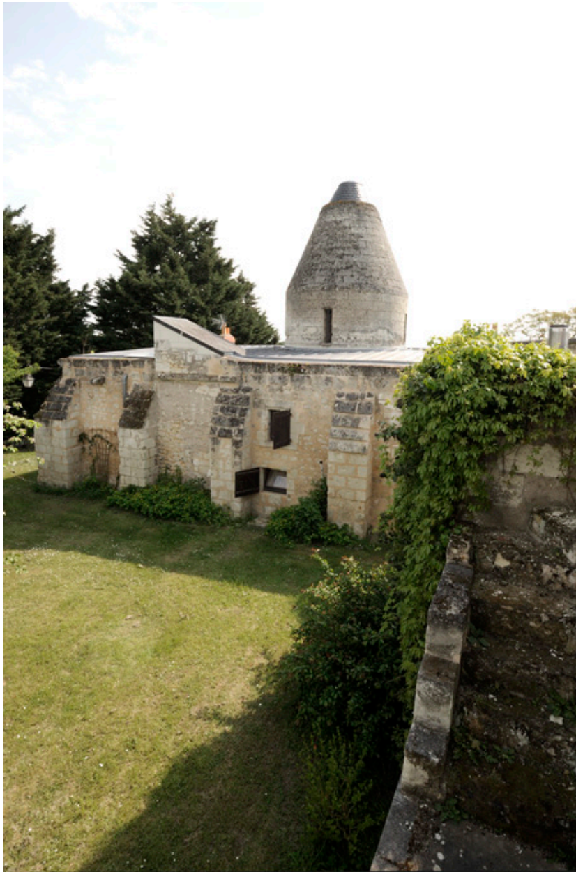
Moulin Neuf : façade nord (vue depuis l'escalier extérieur du Moulin Picard).
