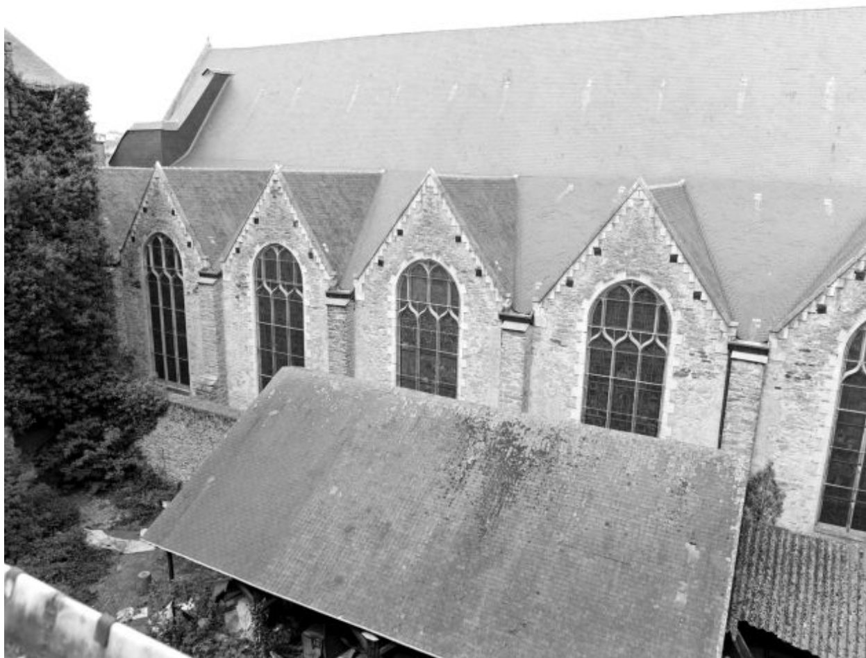
Eglise, bas-côté sud : vue d'ensemble.
