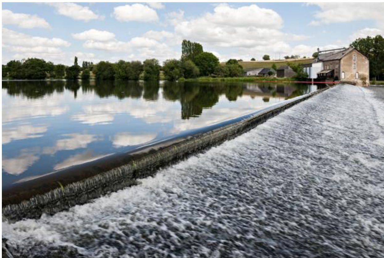
Vue du barrage et du moulin depuis le moulin de la Petite-Bavouze, situé rive droite.
