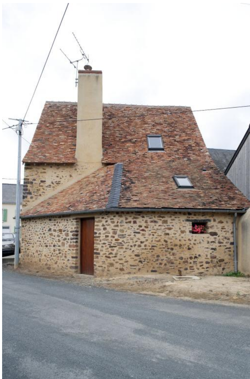
Vue depuis l'angle formé par la rue du Bas-Château et le chemin du laurier.
