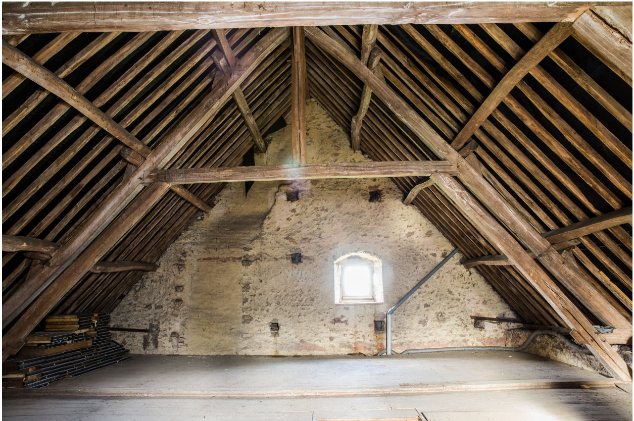
Le comble et la charpente.
