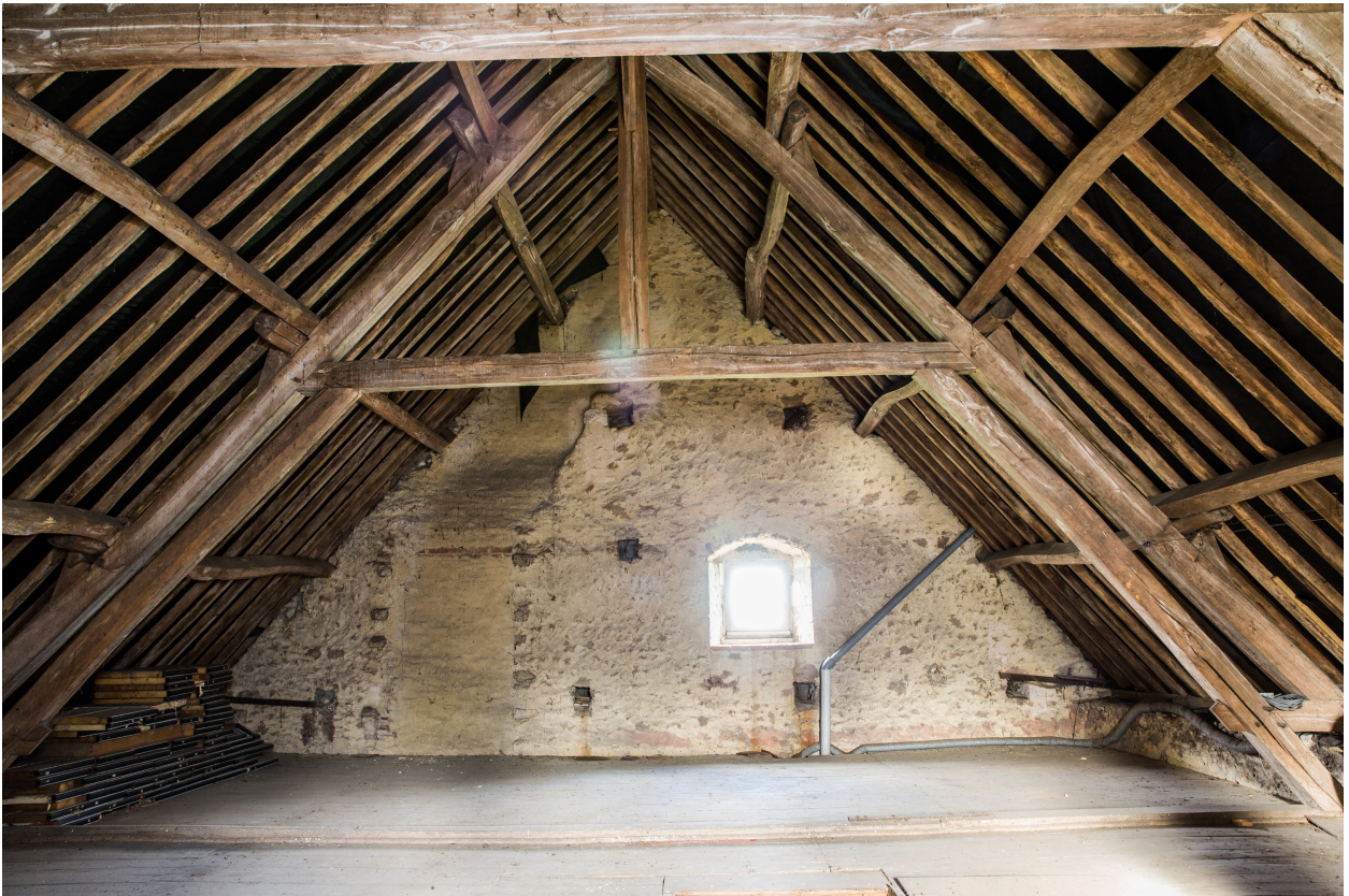
Le comble et la charpente.
