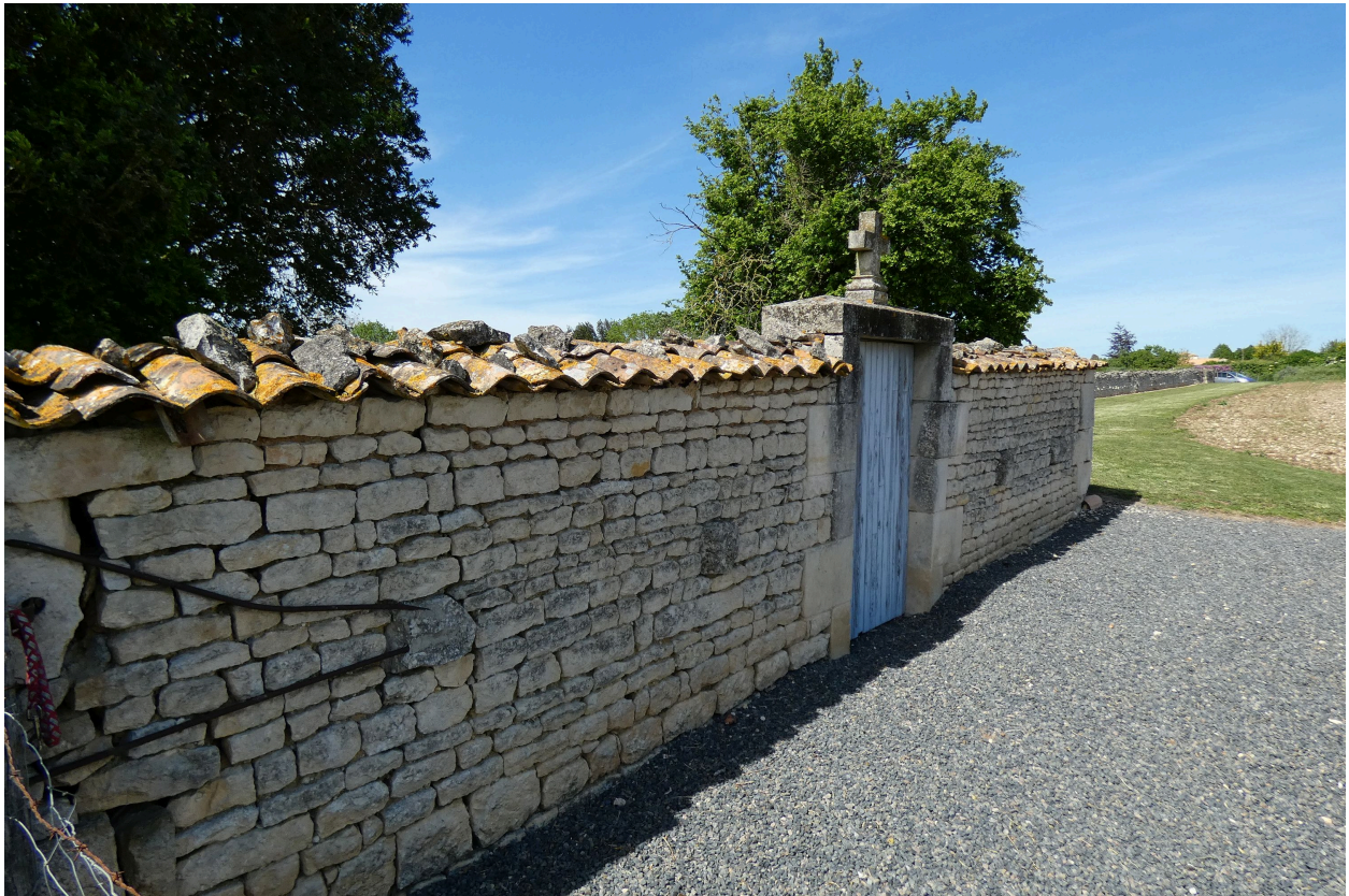
Le cimetière et sa porte piétonne vus depuis le sud-est.
