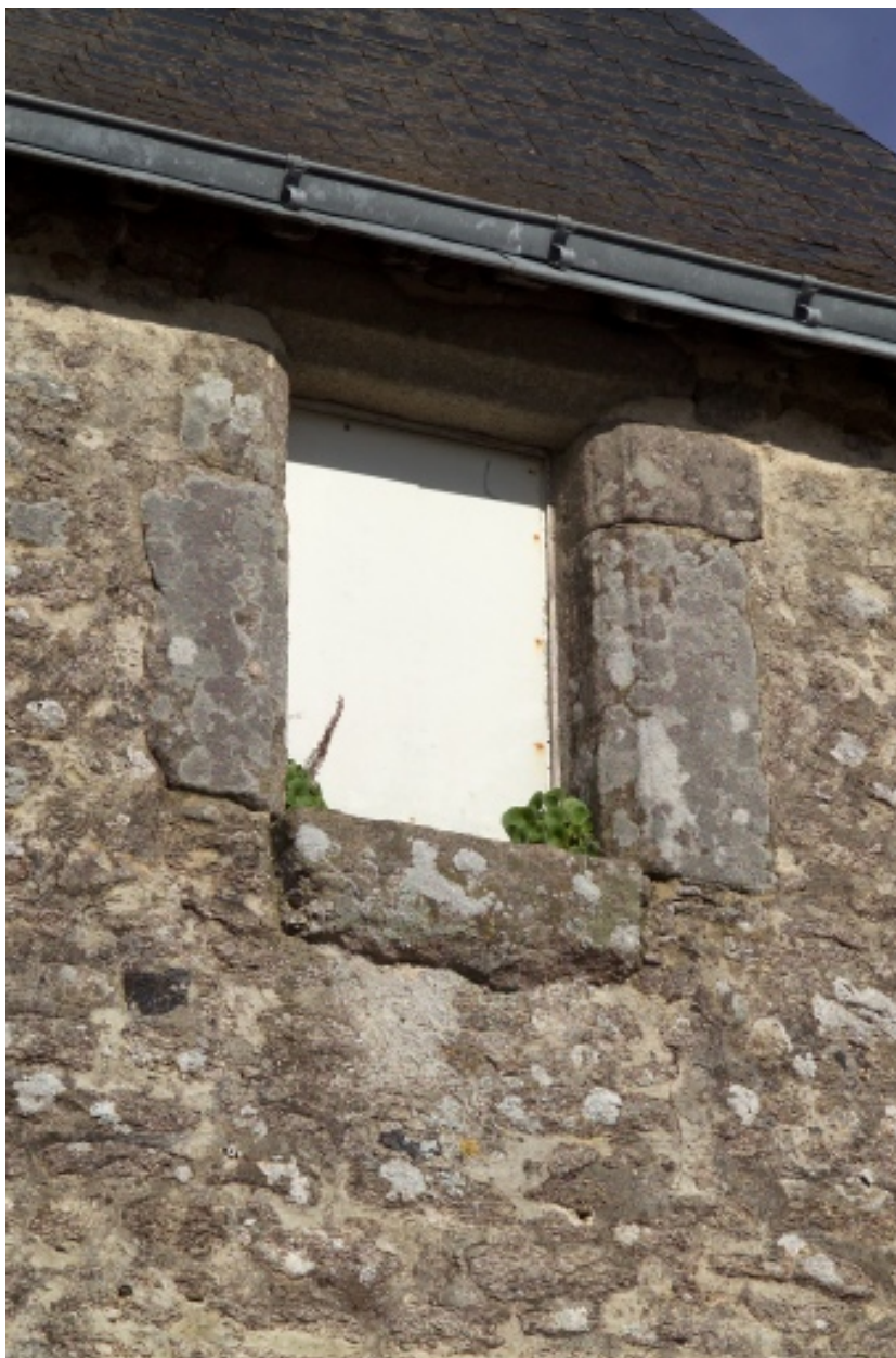
Tour quadrangulaire. Détail de la fenêtre sud.
