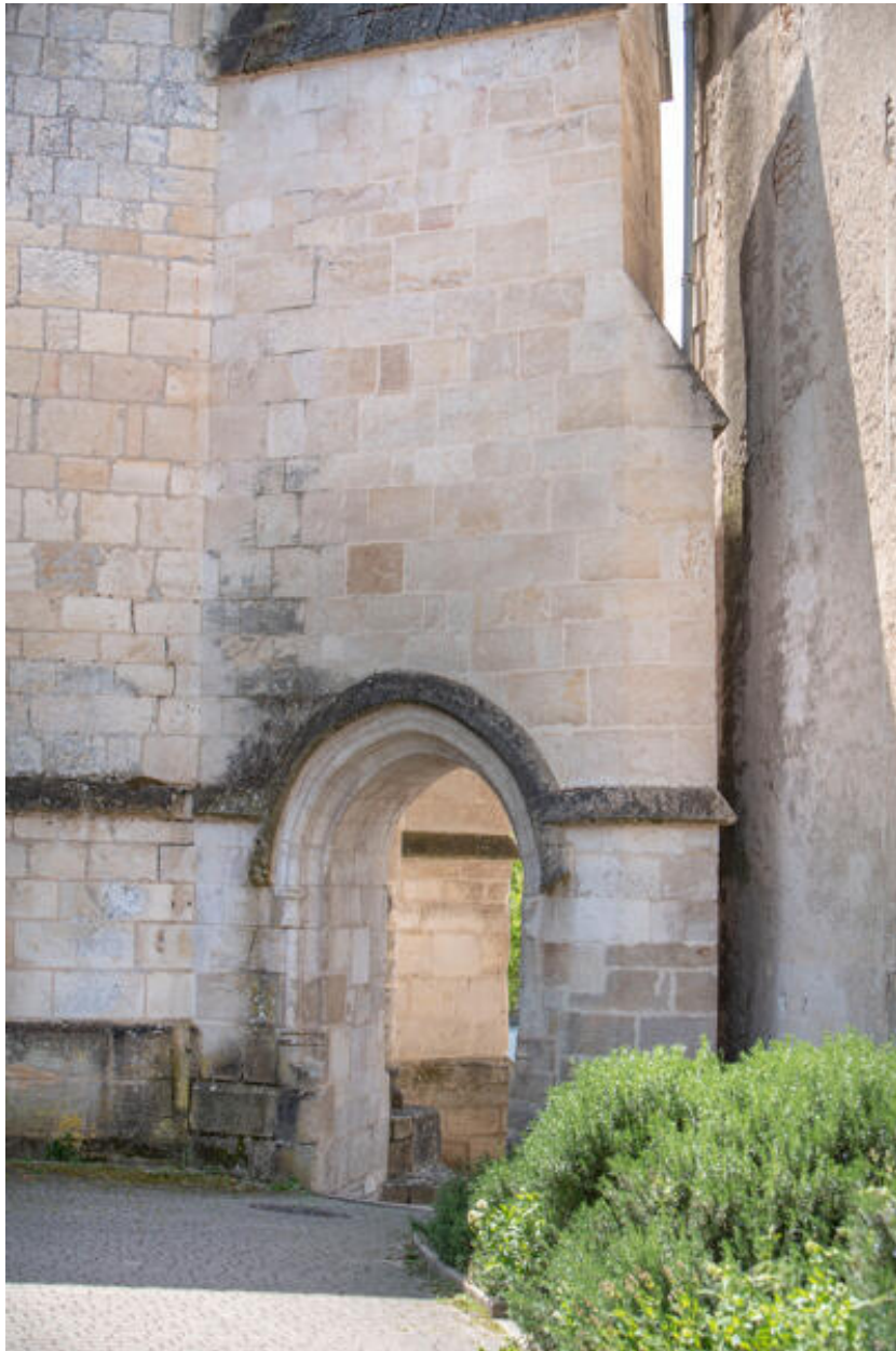
Passage percé dans le contrefort nord-ouest, vu depuis le nord.
