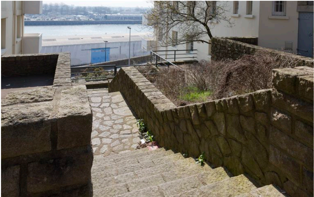
Escalier situé entre les bâtiments E et F.
