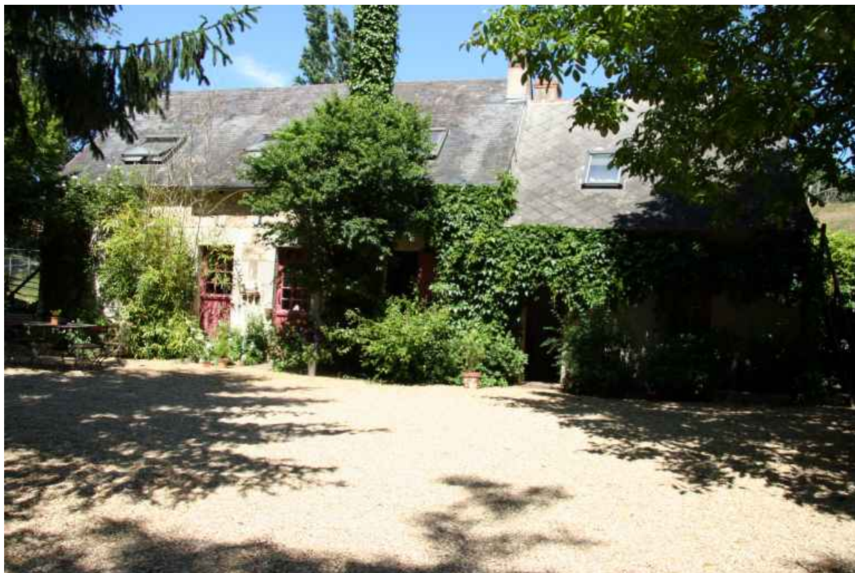
Façade antérieure sur cour.
