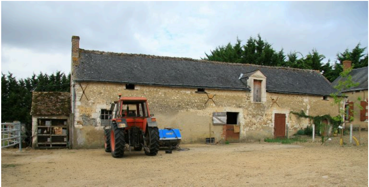
La vieille maison et dépendances sous un même toit remanié : façade sur cour.
