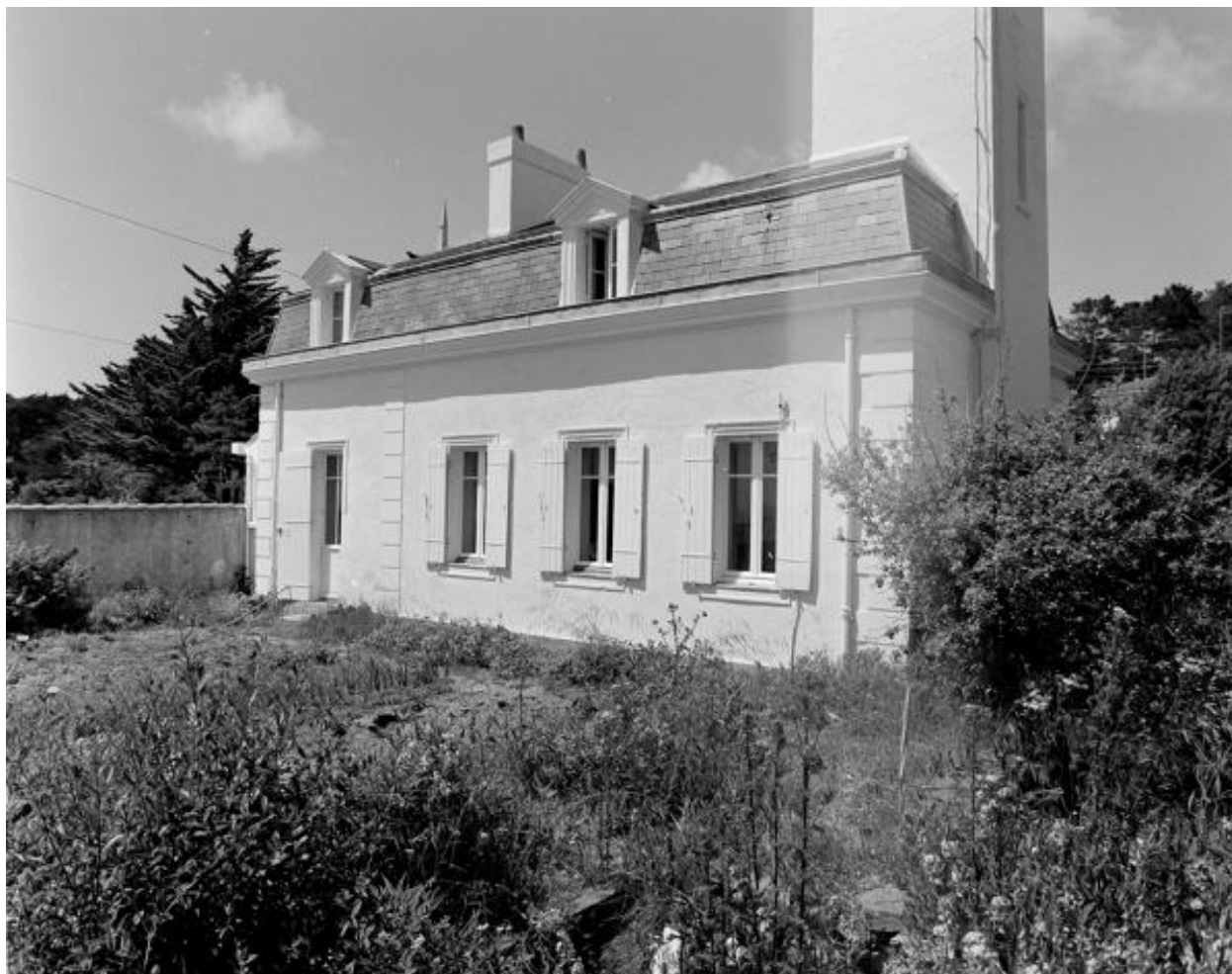
Logement du gardien.
