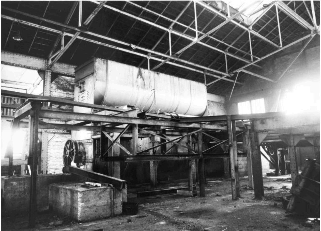
Nouvelle usine. Bâtiment non précisé. Fabrication des sucres granulés. Malaxeur en place.
