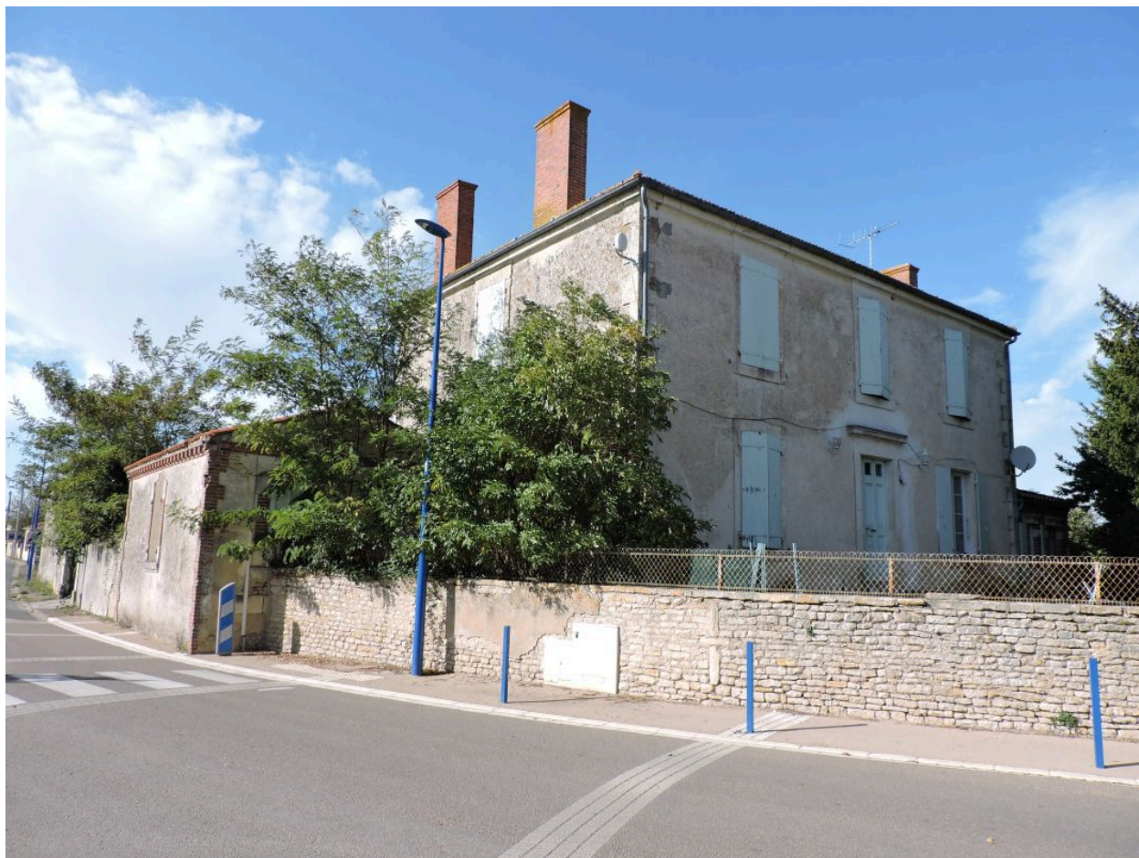
La maison vue depuis le sud-est.
