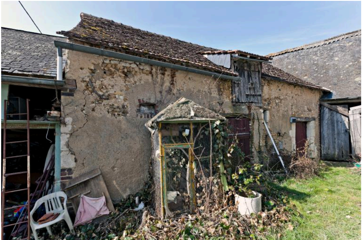
Etable, façade antérieure sur cour, face à la maison.
